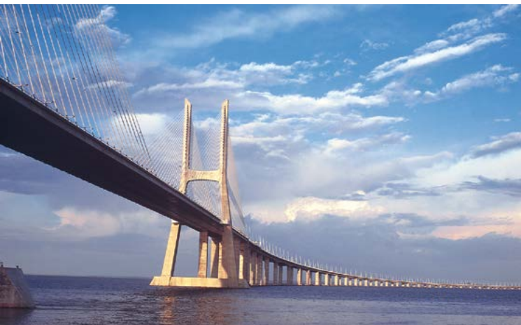
Pont Vasco de Gama sur le Tage à Lisbonne (Portugal) 1997. Constructeur Vinci.
