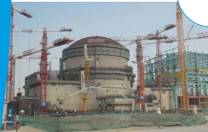
Centrale nucléaire de Taishan (EPR) 2011. Enceintes en béton précontraint. Conception Areva, Framatome, EDF.
